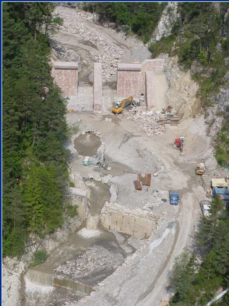
Intervento in corso di esecuzione
