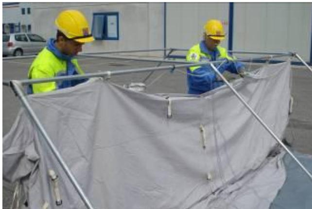
Lo srotolamento va effettuato parzialmente in modo da poter permettere l'ancoraggio dei ganci sulla parte centrale del tetto (colmo) senza calpestare il telo camera.
