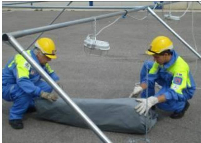
Stendere il telo camera a terra sotto la struttura, srotolarlo senza aprirlo completamente.
