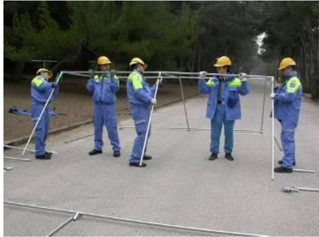
La struttura va SEMPRE sorretta al centro dei pali e occorre ricordarsi di inserire il palo porta, il palo costituente la struttura della porta di accesso, come indicato nelle immagini sottostanti.
