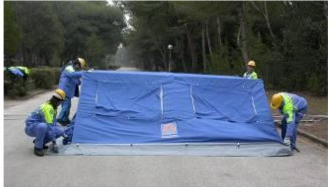
Solo ora si procede al montaggio dei pali montanti delle pareti della tenda.
