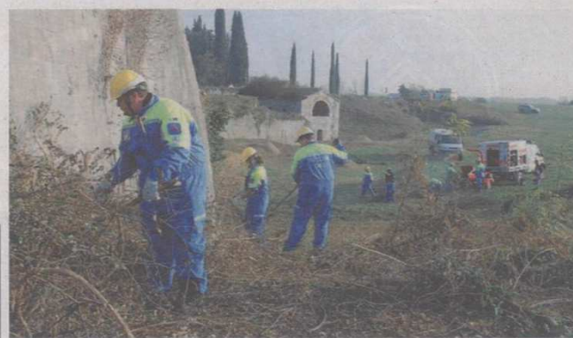
Impegno I volontari della Protezione civile al lavoro per ripulire le antiche mura di Palmanova
